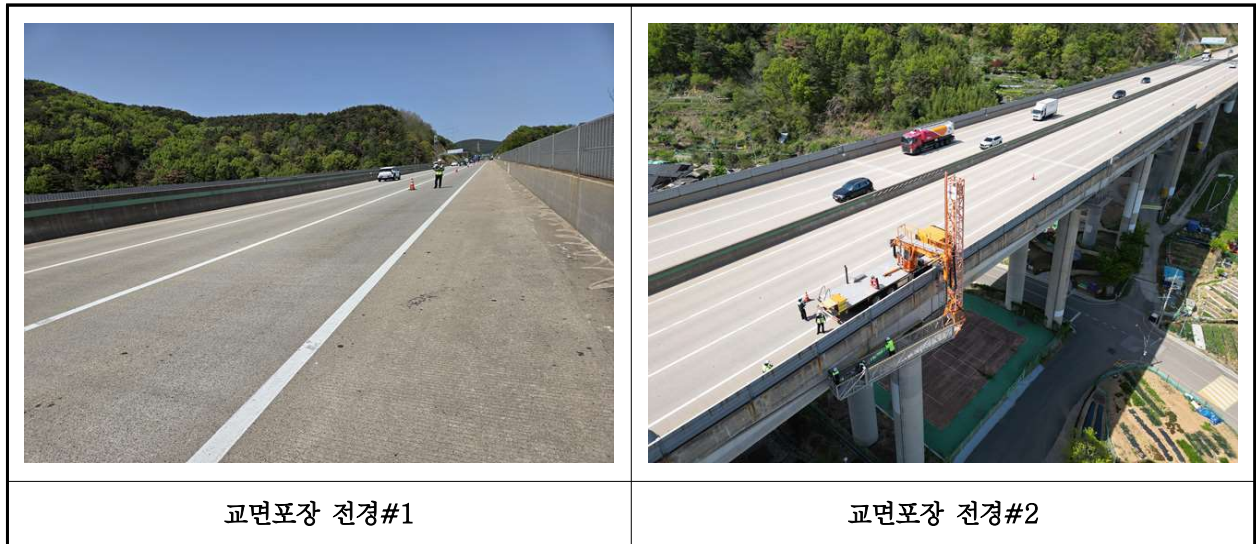
【사진 36.3.20】 교면포장 전경
