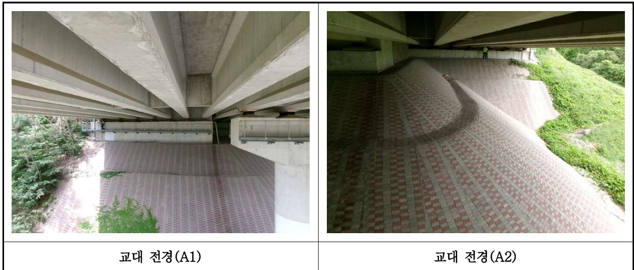
【사진 36.3.8】 교대 전경
