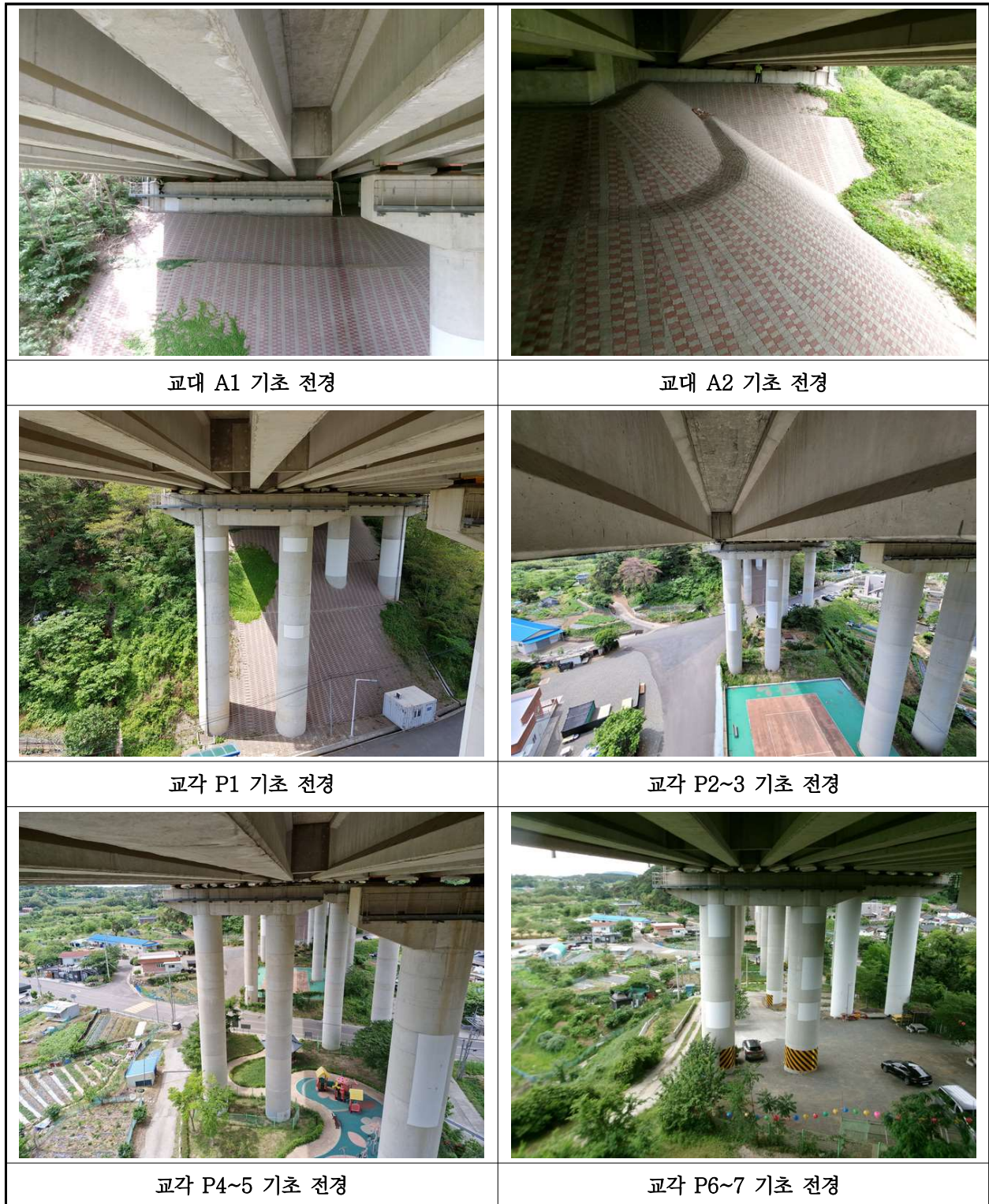
【사진 36.3.12】 기초 전경
