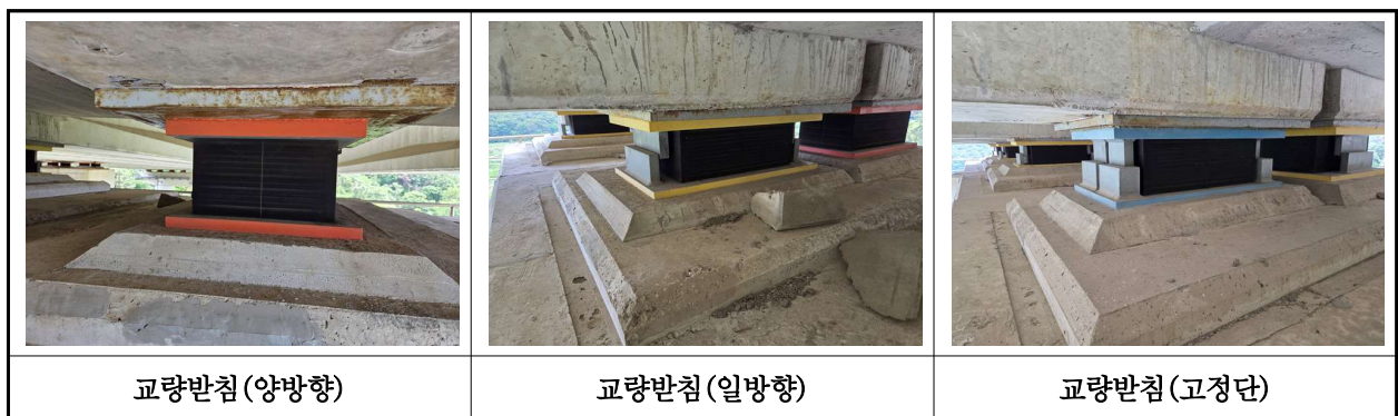
【사진 36.3.13】 교량받침 전경
