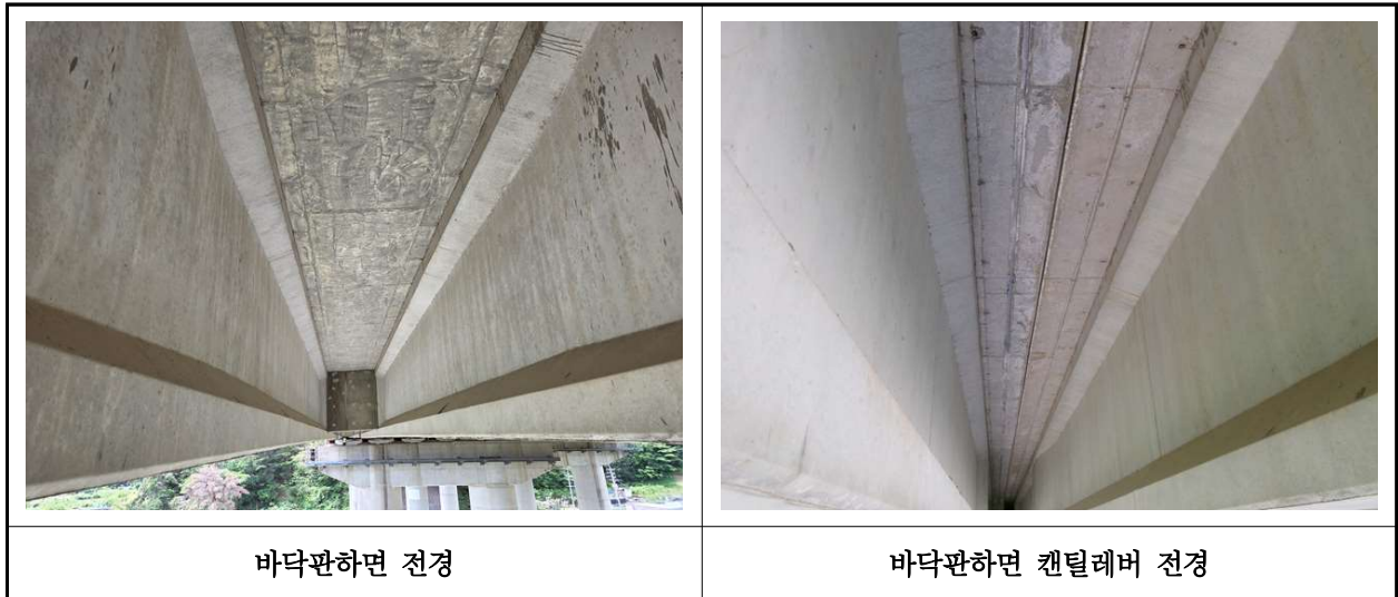
【사진 36.3.2】 바닥판하면 전경
