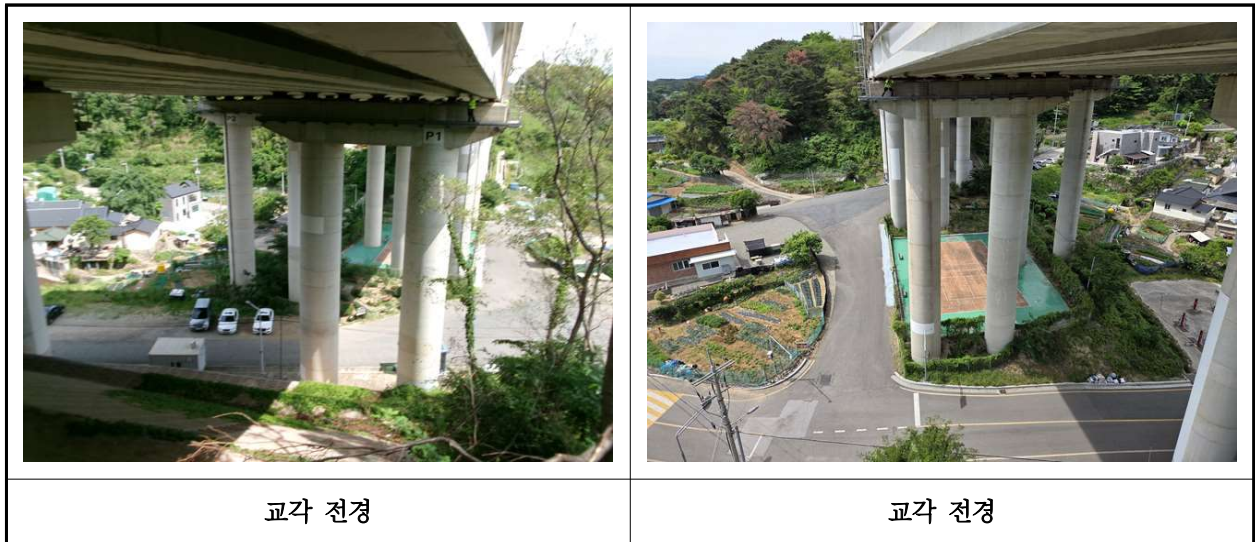
【사진 36.3.10】 교각 전경
