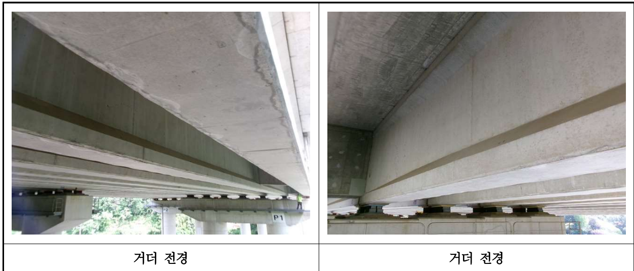
【사진 36.3.4】 거더 전경
