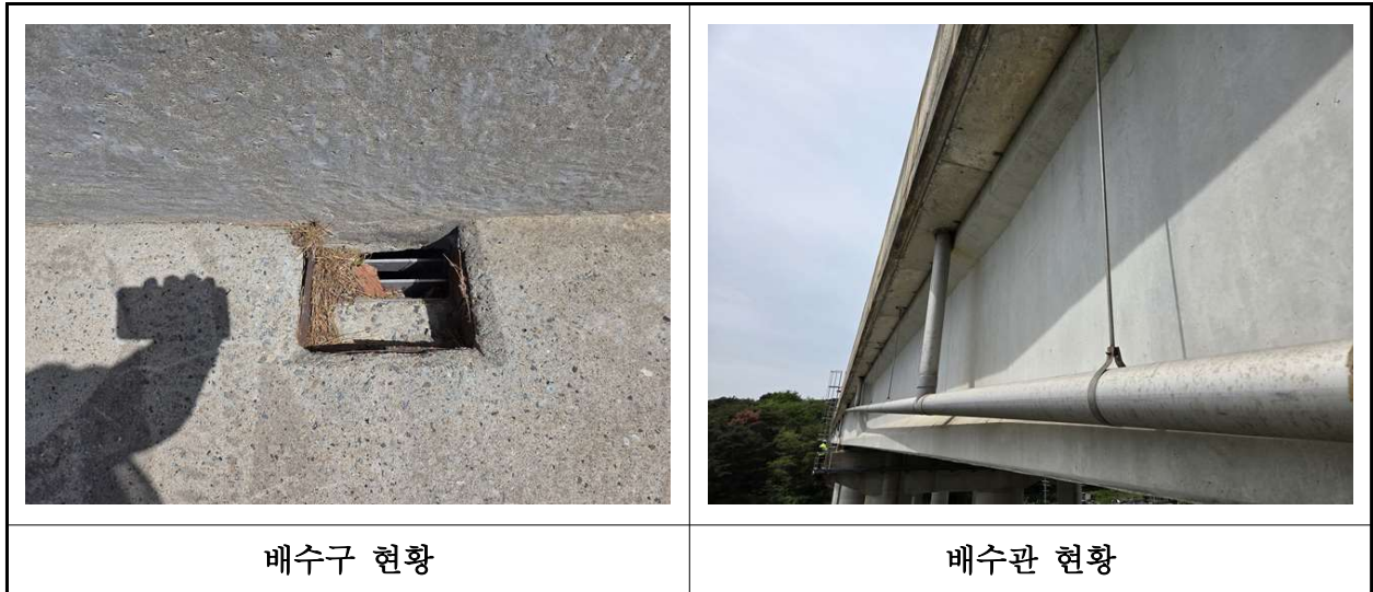
【사진 36.3.22】 배수시설 전경
